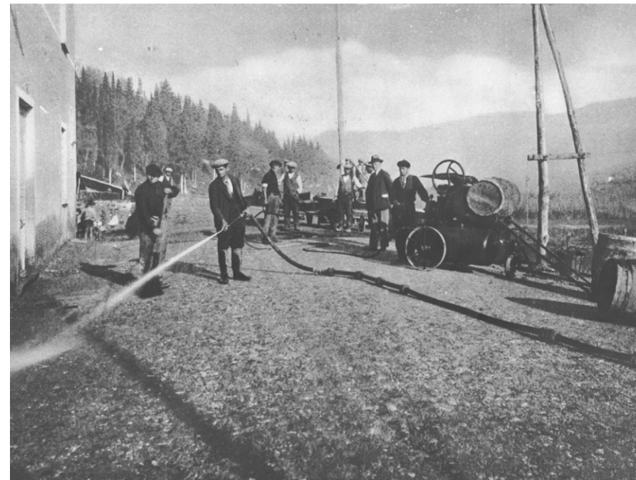
I primi lavori di asfaltatura della strada provinciale negli anni Trenta del Novecento (Archivio fotografico Fondazione CDSE, fondo Fiondi)
